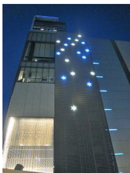
③ビル イルミネーション 南側壁面 LED
